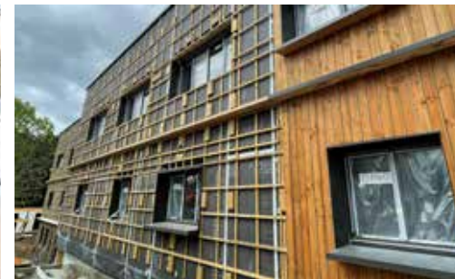
Pose des façades à ossature bois sur le chantier du futur Campus Datascience et Cybersécurité
