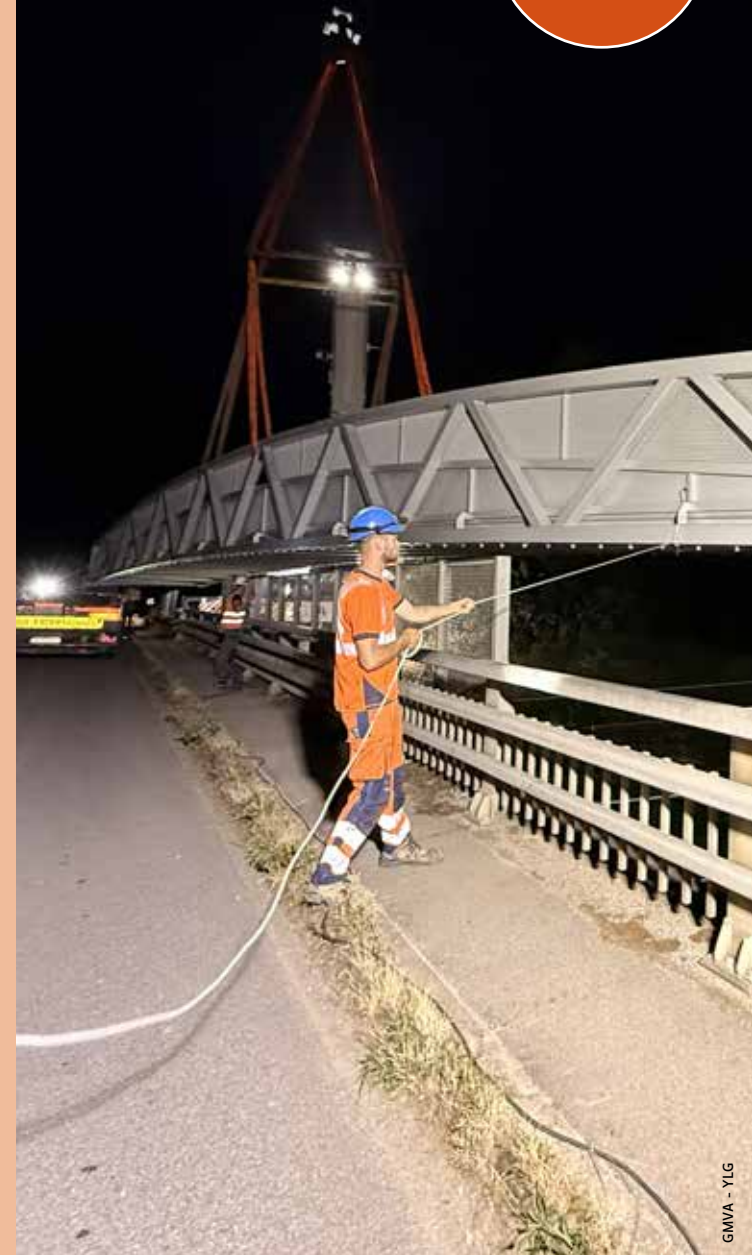
Pose de la passerelle cyclable entre Vannes et Plescop.
